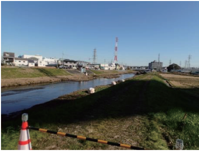
図 3 西久保橋上流側 (No. 1) (2019. 1/11, 浚渫工事中)
