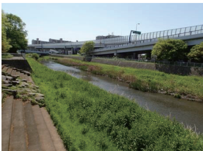
図 9 中原橋-下町屋橋間 (No. 6) 親水スペース (2018. 4/19)
